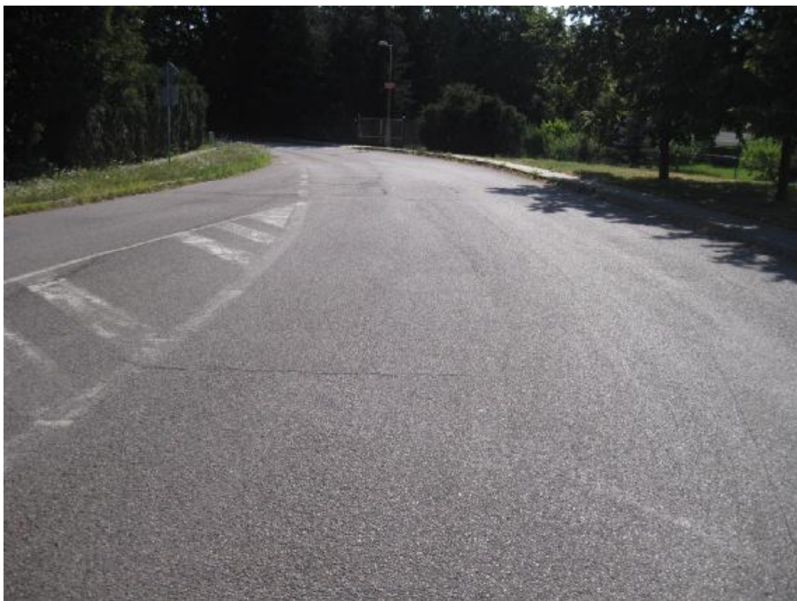
F23, km 3,660- Příčná trhlina tenká.
