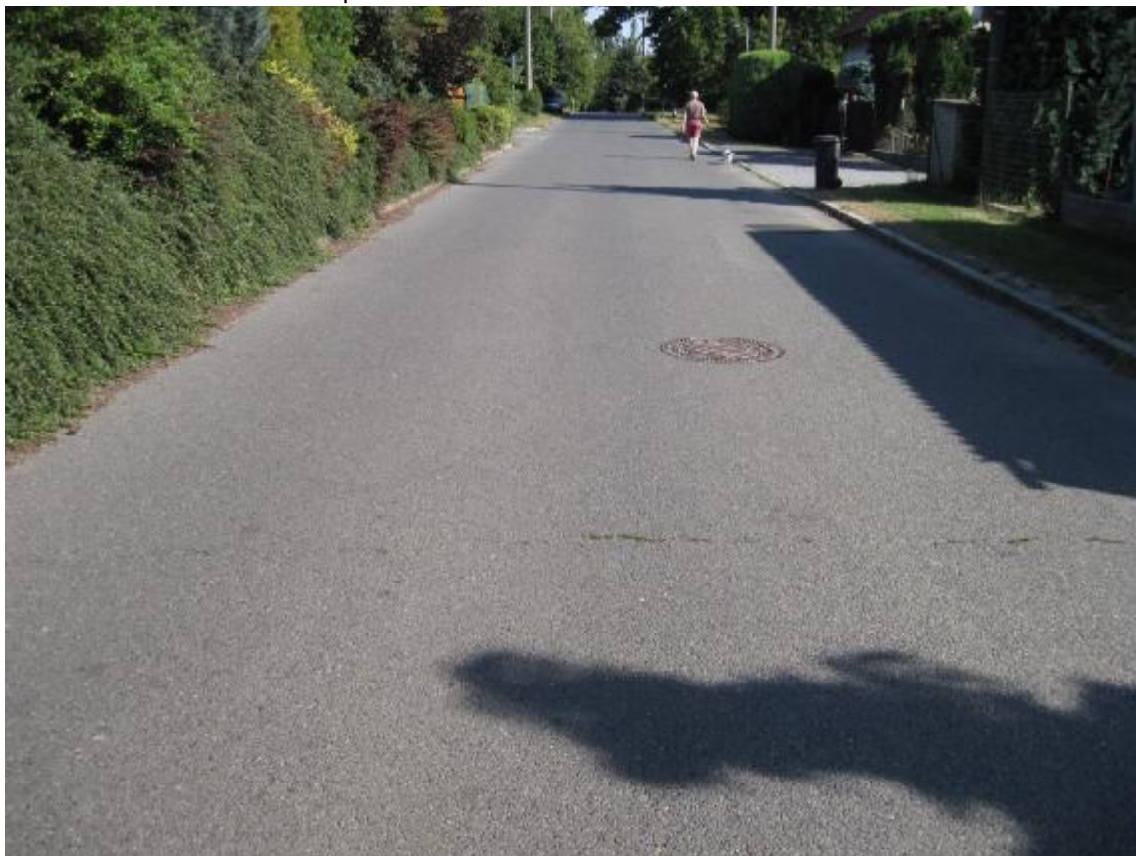
F12, km 2,230- Příčná trhlina.
