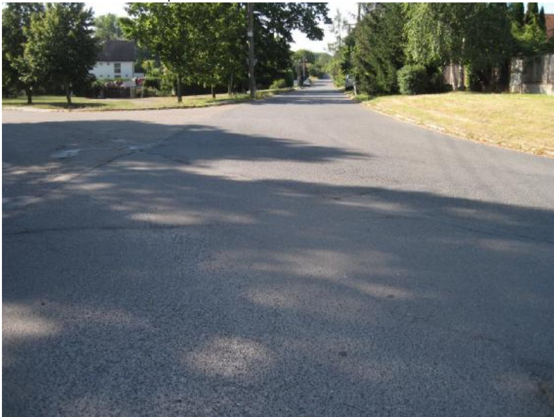
F03, km 2,067+ Ztráta asfaltového tmelu až hloubková koroze v prostoru křižovatky.
