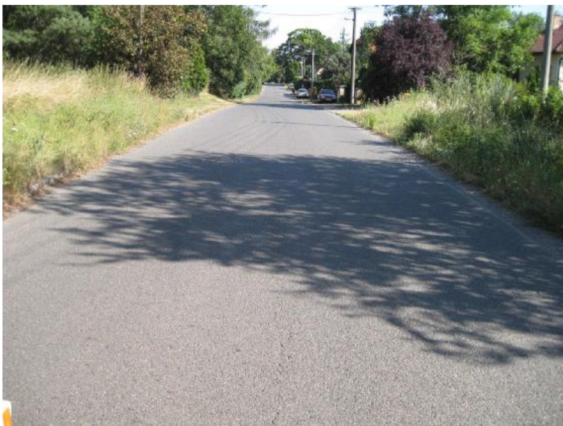
F16, km 2,330- Podélná rozvětvená trhliny uprostřed.
